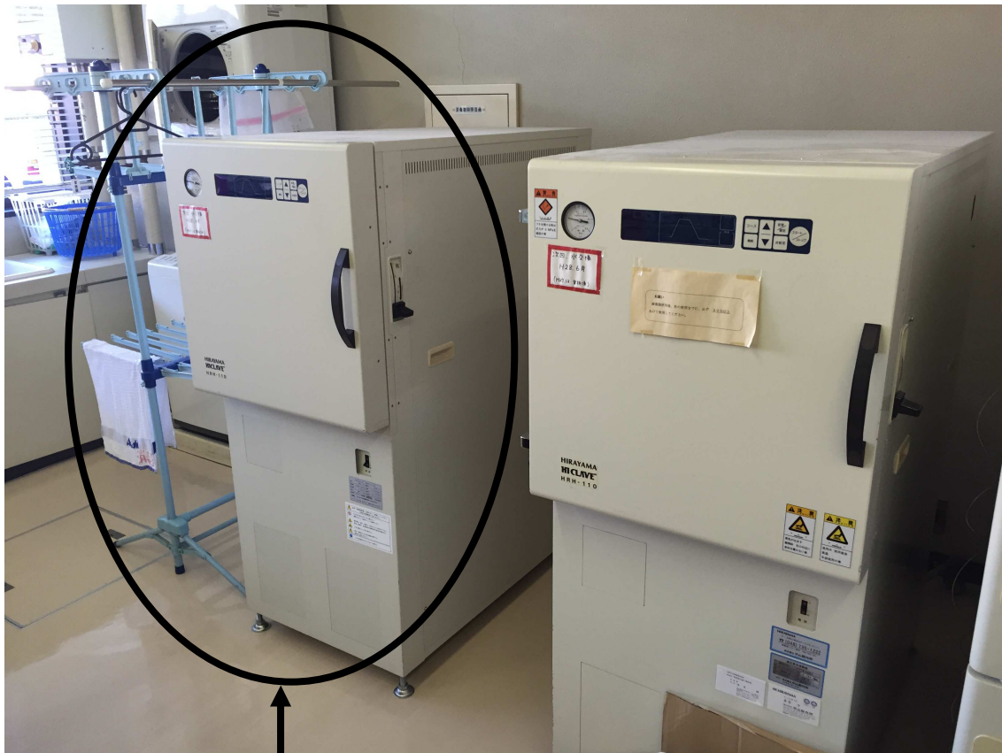
撤去し、納入機器を入れる
