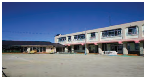
中規模改修後の園舎外観(西部保育園)
