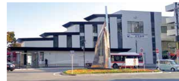
名鉄新城駅の駅舎改修
