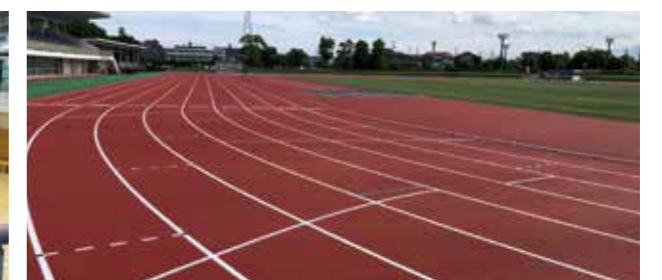
陸上競技場の改修
