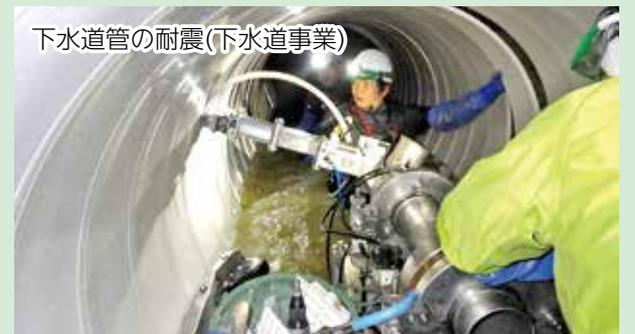
下水道管の内側に新しい管を形成して補強している様子です。このように、下水道管の耐震を進めています。
