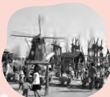
大型木製遊具の設置等、デンパーク「風車の広場」を改修
