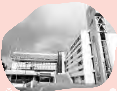
アリーナ床の張り替えや照明のLED化等、市体育館を改修
