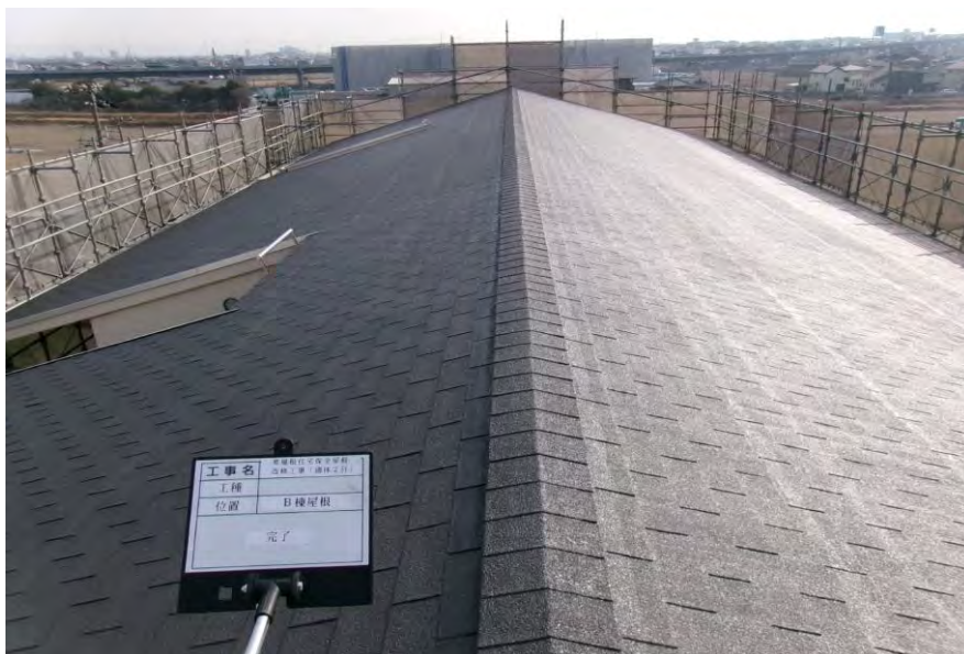
寒風根住宅保全屋根改修工事
