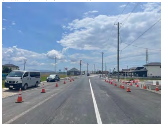
新明東栄線工事箇所写真 池浦町池上交差点から南
