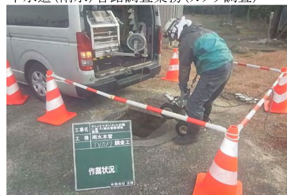
下水道(雨水)管路調査業務(カメラ調査)
