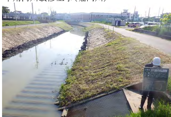
準用河川改修工事(堀内川)
