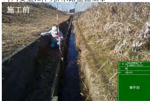
町内要望に伴う排水路整備工事
