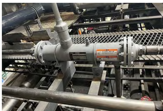
【熱交換器取替修繕】
