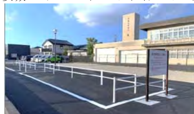
新安城駅北口駐輪場
