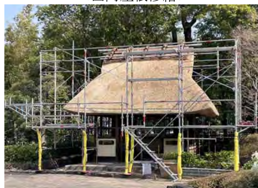
<四阿屋根修繕>
