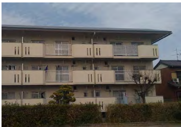
大山田上住宅外部保全工事
