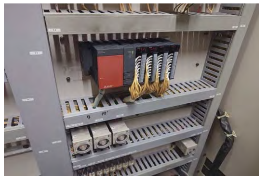
【造波装置制御機器取替修繕】
