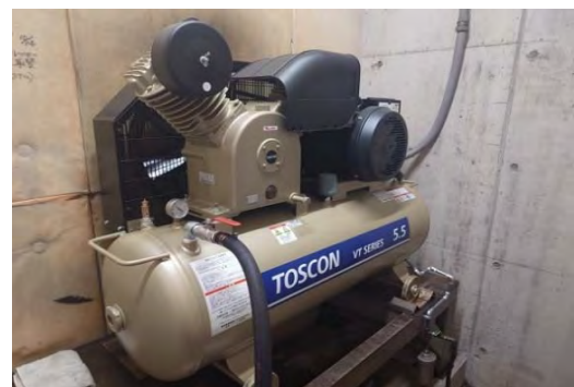
【造波コンプレッサー取替修繕】
