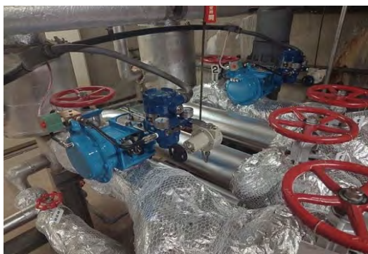
【蒸気供給圧力制御弁ほか更新修繕】
