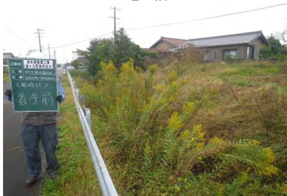
町内要望に伴う排水路整備工事 ＜施工前＞
