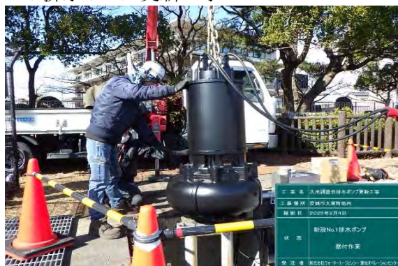
大池調整池 ▼排水ポンプ更新工事
