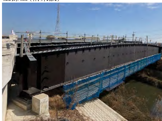
上部工(桁架設)
