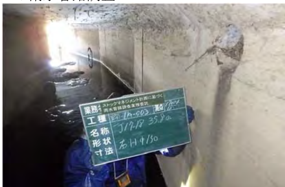
雨水施設調査業務 ▼雨水管路調査
