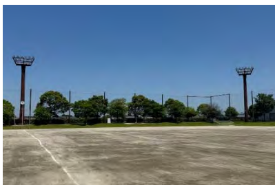
<多目的グラウンド夜間照明>
