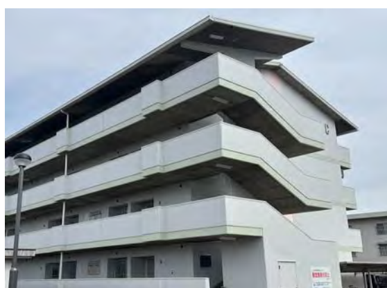
池浦住宅C棟外部保全工事
