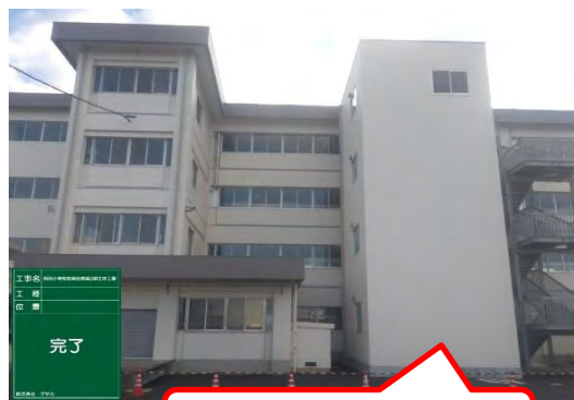
エレベーター棟の設置
