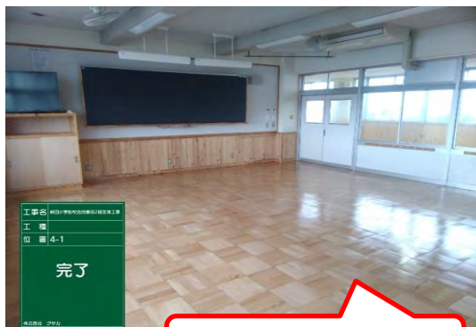
普通教室の床の改修
