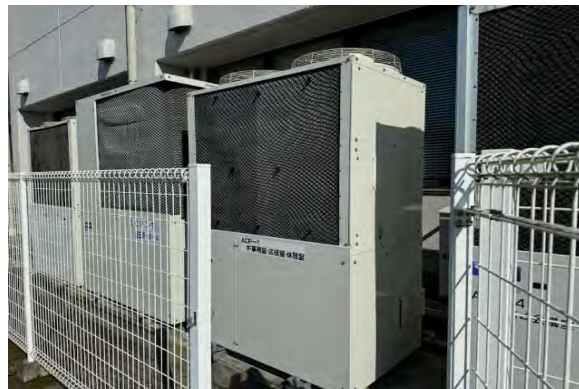
< 事務室系統空調設備更新修繕(室外機) >
