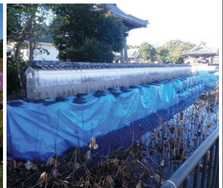
<石垣を大型土のうで保護>
