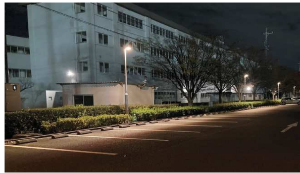
【照明設備更新工事(第1駐車場)】
