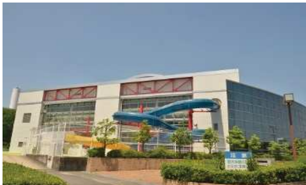
【安城市レジャープール 全景】
