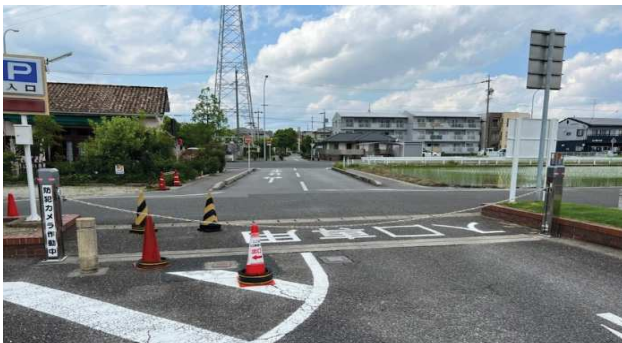
【第2駐車場チェーンオートゲート修繕】
