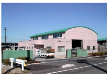
写真：せん定枝リサイクルプラント
