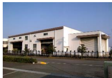
写真：資源化センター
