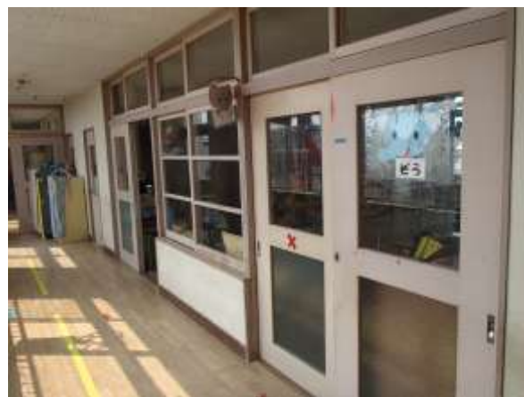
園舎外観と内部の様子
