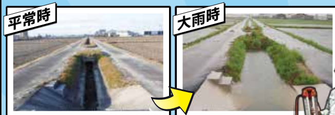
水路流量調整方式による水田貯留の様子
