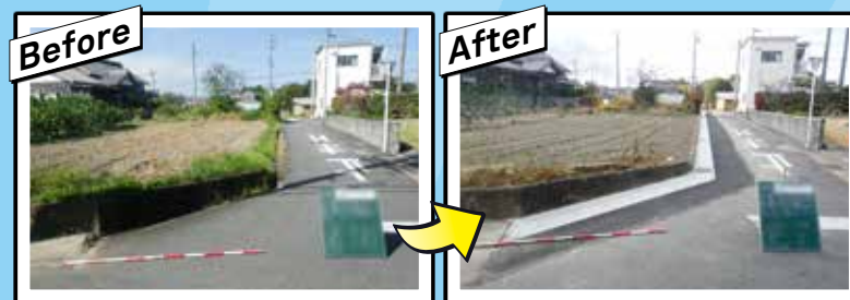
道路側溝整備工事
