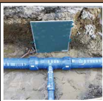
耐震管布設の様子
