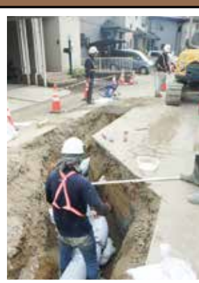
改築工事の様子
