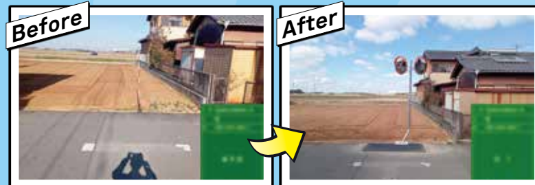
道路反射鏡設置工事
