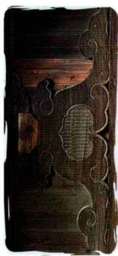
▲覆殿の臺股 本殿の臺股と異なり、彫刻が多くついています。一般的に臺股は時代が下ると複雑化します。
