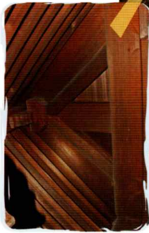
▲本殿の又首組 二本一組で斜めに組んだ材を連続的に並べて屋根を支える小屋組です。合掌造などの急勾配な屋根にも使われます。
