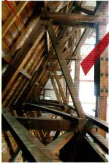
▼梁の上から撮影
