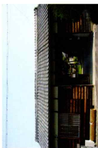
構造様式：長屋門 切妻造 棧瓦葺 東面庇付、北面庇下し
