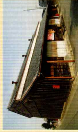
構造様式：土蔵造平屋建、前室付 建築年代：昭和15年築
