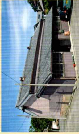
① 構造様式：土蔵造平屋建、前室付 建築年代：昭和8～9年築
