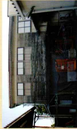
農業倉庫 構造様式：木造2階建 寄棟造 建築年代：昭和30年野田村(刈谷市域)から移築
