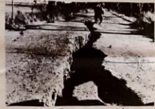
地震による地割れ
