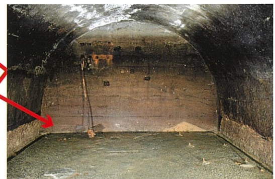
▲ ① 機械の痕跡（南から） 壁から太いケーブルが伸びたままになっています。床には機械を固定したボルトや穴が残っています。
