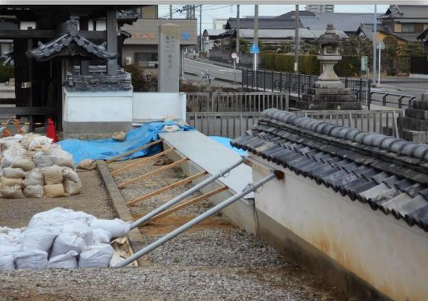
内堀塀の傾きによりひび割れ、石垣に隙間が見られるようになり、2年程かけて修復工事が始まりました。
