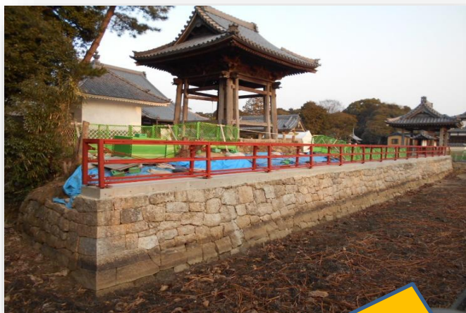
石垣の上に鉄の枠が据えられました。 (3/9、12撮影)
