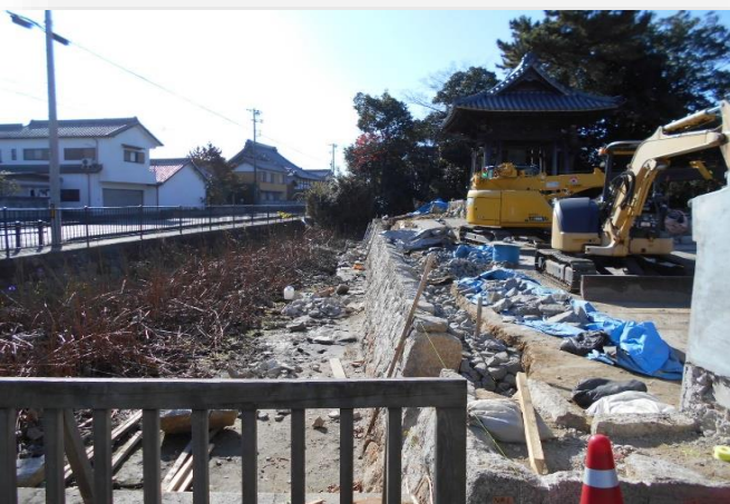
石垣の積戻しが終盤となっています。(12/12撮影)
