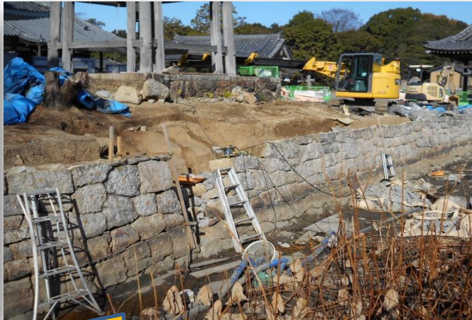
石垣の積戻しが終盤となっています。(12/12撮影)
