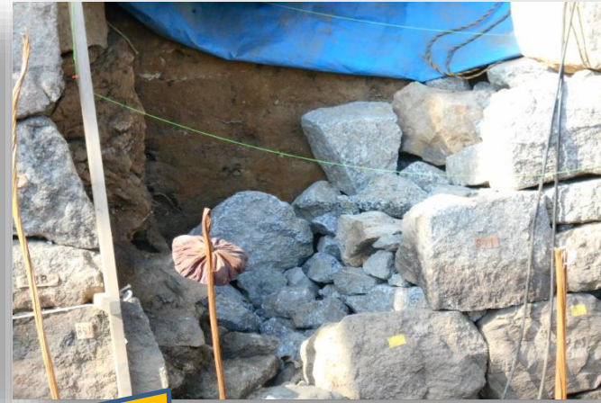
石垣が元の位置に積み、内側にも石が積みられています。(11/12撮影)
