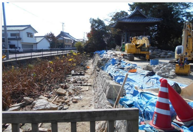
石垣が元の位置に積み、内側にも石が積みられています。(11/12撮影)
