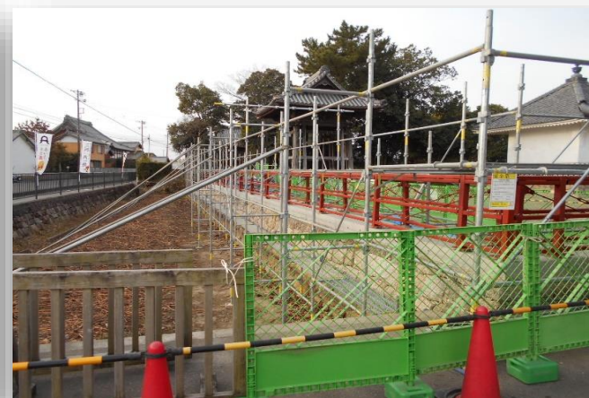
石垣の上に鉄の枠が据えられました。 (3/9、12撮影)
