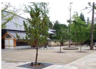
洗い出しコンクリート舗装 (史跡東大寺旧境内)
