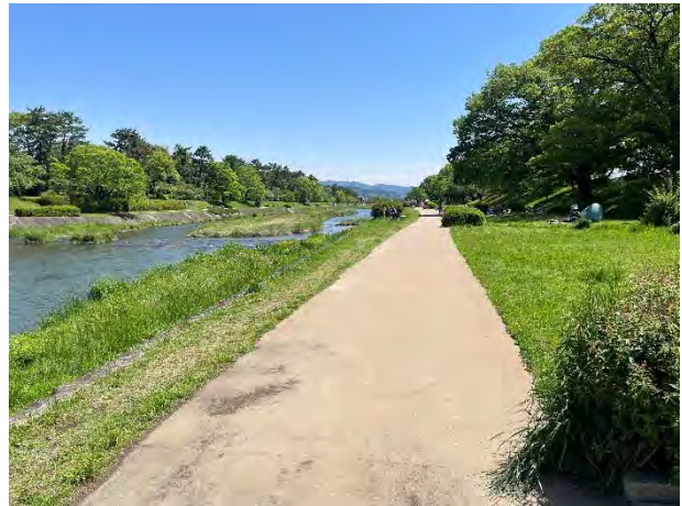
高炉スラグ舗装の整備事例(鴨川河川敷)
