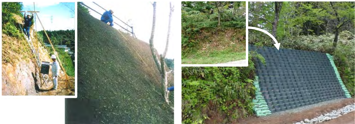
ジオファイバー工法(史跡仲仙寺古墳群)
