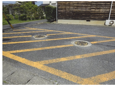
県道脇市有地に設置された 防火水槽
