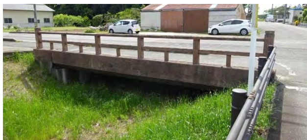
歩道部分は張り出している
