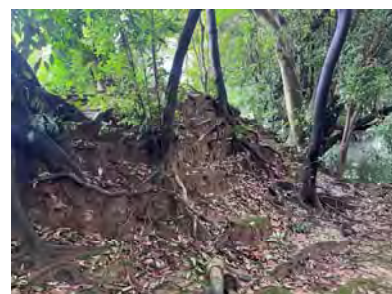
築山の表土の流出
