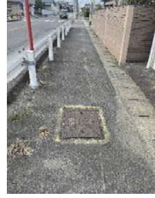
公民館横にある 屋外消火栓
