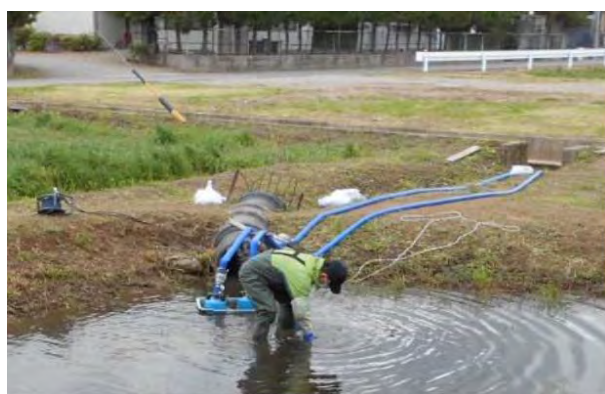
ポンプによる排水 令和3年(2021)4月「ハスの会たより」より
