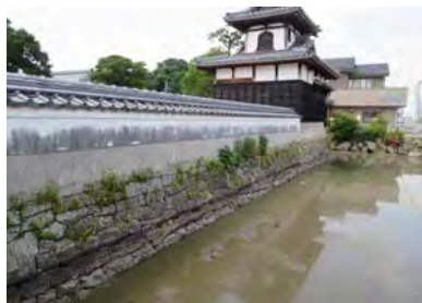
本堂東側の堀 RC造で再建されている
