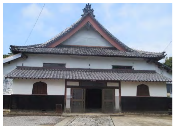
庫裏：後年増築された玄関部分
