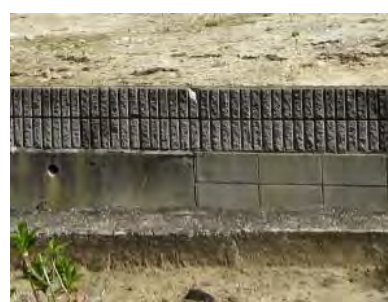
コンクリート擁壁
