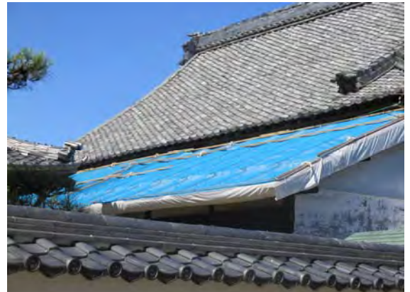
庫裏：屋根の応急処置
