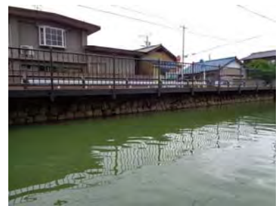
内堀に張り出した県道の歩道 下部は道路拡幅に伴う石積
