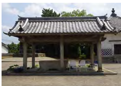
◆水屋(コンクリート造)
