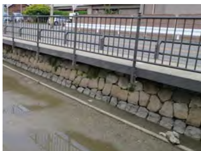
道路側石積護岸
