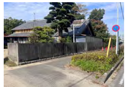
住宅のコンクリート塀
