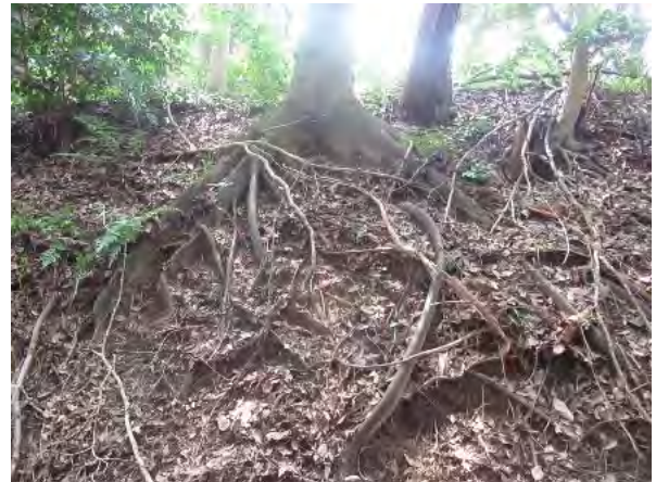
東側内土塁北側周面 表土の流出により樹根が露出している
