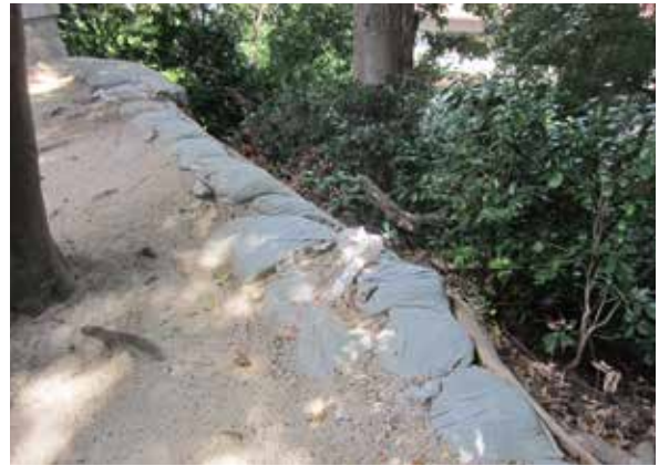
図 48 後円部の土砂流出を防ぐ土嚢④
