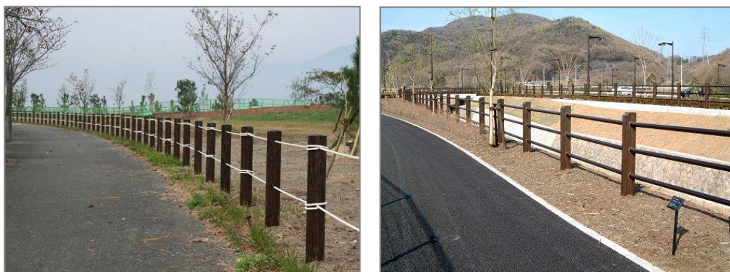
6-9-1 転落防止柵（イメージ）
