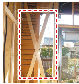
耐震改修工事の一例
