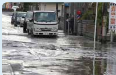
液状化 地盤が液体のように柔らかくなります(写真提供 香取市)
