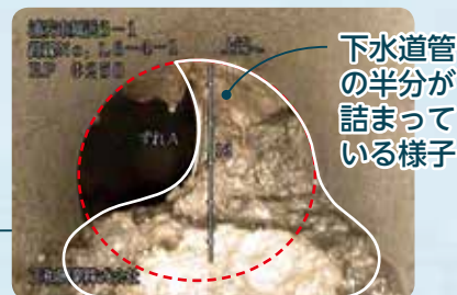
下水道管の破損 トイレや台所等の水が流れなくなります
