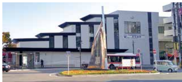
名鉄新安城駅の駅舎改修
