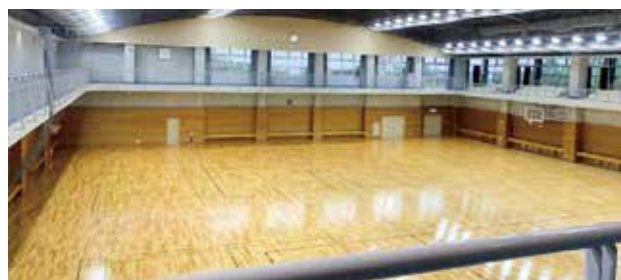
スポーツセンターの改修
