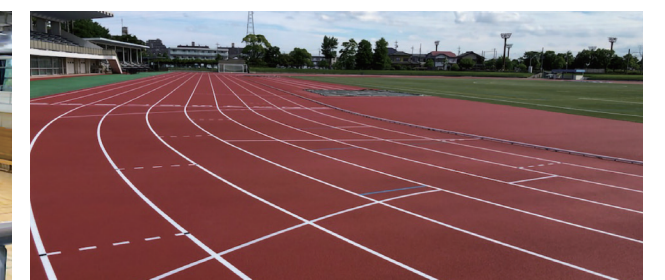
陸上競技場の改修
