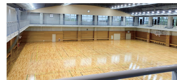
スポーツセンターの改修
