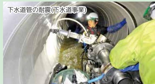
下水道管の内側に新しい管を形成して補強している様子です。このように、下水道管の耐震を進めています。
