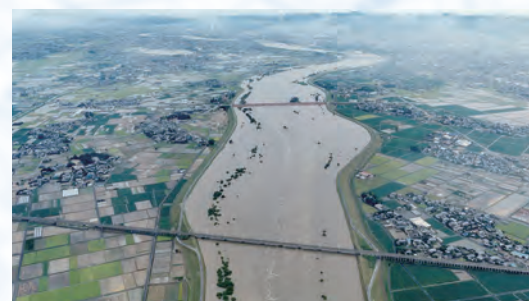
平成12年東海豪雨翌日の矢作川 (東海道新幹線付近)
