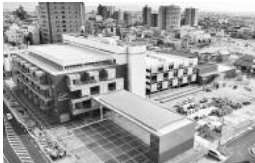
▲開館に向け建設が進むアンフォーレ(3月7日撮影)
