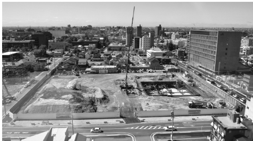
建設工事の進む中心市街地拠点施設(9月11日撮影)
