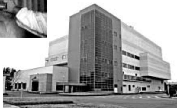
平成9年に完成した環境クリーンセンター。
