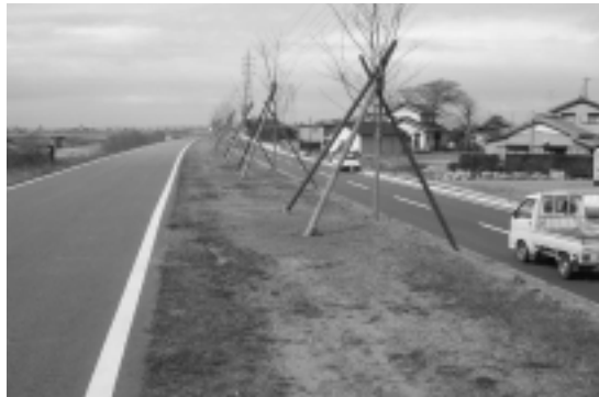
矢作川堤防(藤井町)
