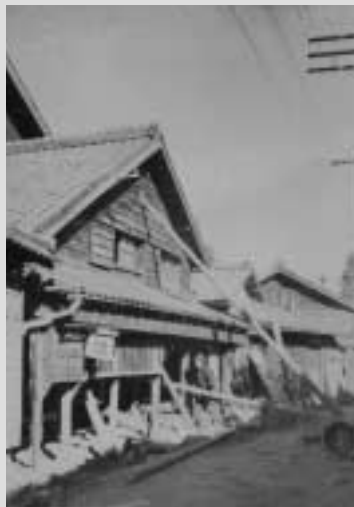
東南海地震で傾いた家(現碧南市湖西町) ※この建物が三河地震で倒壊し、右ページ写真のようになった。／ 原田三郎氏撮影・提供(昭和20年1月)
