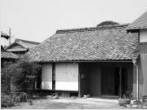
現在も改造されながら残る「工作隊」が 建てた建物（現安城市河野町）
