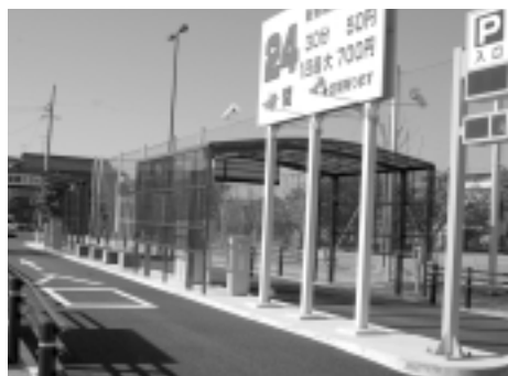
新城駅南駐車場
