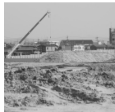
建設が進む1号調整池
