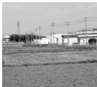
整備中の尾崎高架橋
