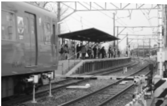
鉄道立体交差事業が予定されている桜井駅周辺
