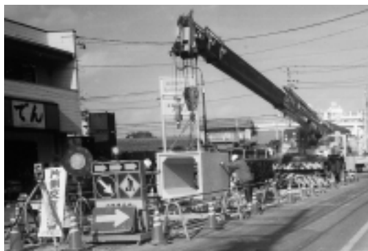
進む下水道整備事業
