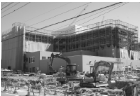
建設工事の進む八千代病院
