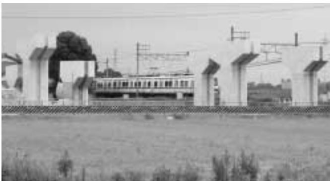
橋脚の工事が始まった豊田安城線
