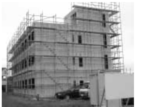
建設中のグループホーム「安城福釜の家」
