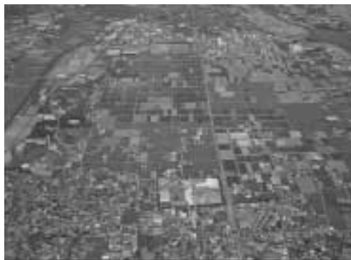
明祥地区工業団地予定地周辺
