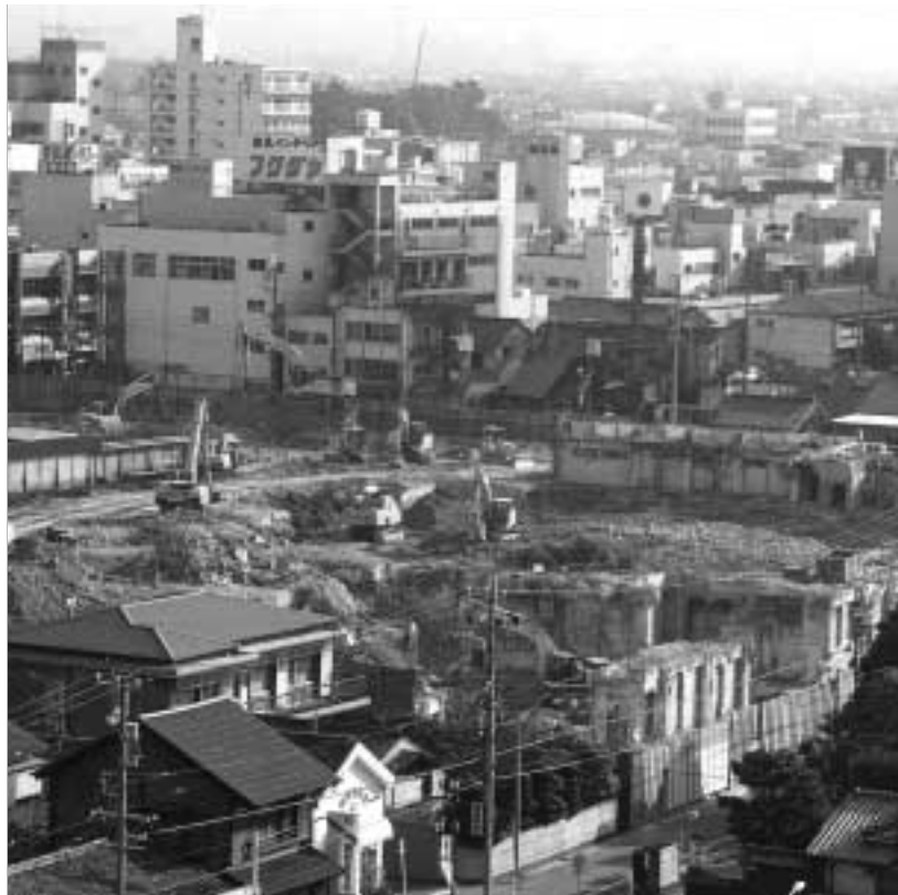
4月末までに解体工事を終え暫定広場となる旧更生病院跡地
