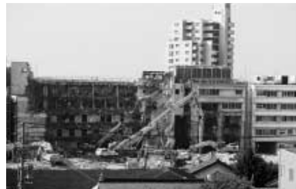
解体作業が進む旧更生病院
