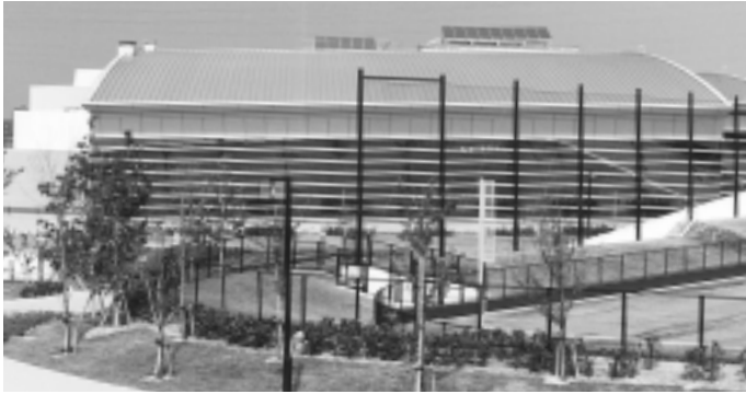
▲スポーツセンターの太陽光発電システム
