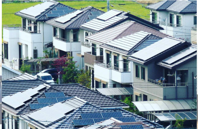
太陽光発電パネルが設置された住宅
