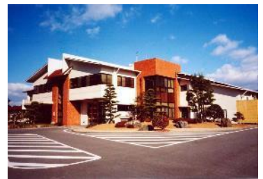
写真：環境クリーンセンター (し尿処理施設)
