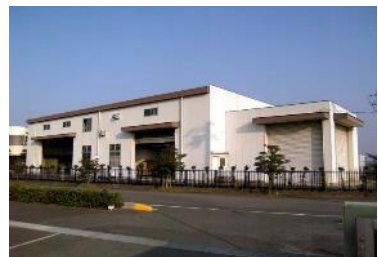
写真：資源化センター
