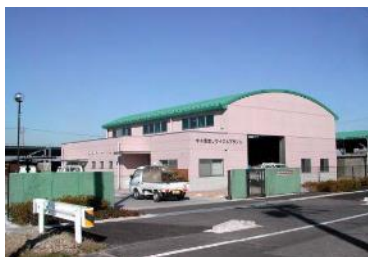
写真：せん定枝リサイクルプラント
