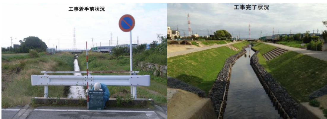
写真：多自然川づくり整備工事（着手前・着手後）
