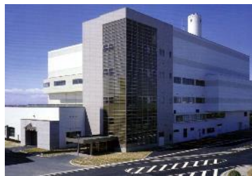
写真：環境クリーンセンター (ごみ焼却施設)
