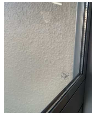
■ 複層ガラスの窓
