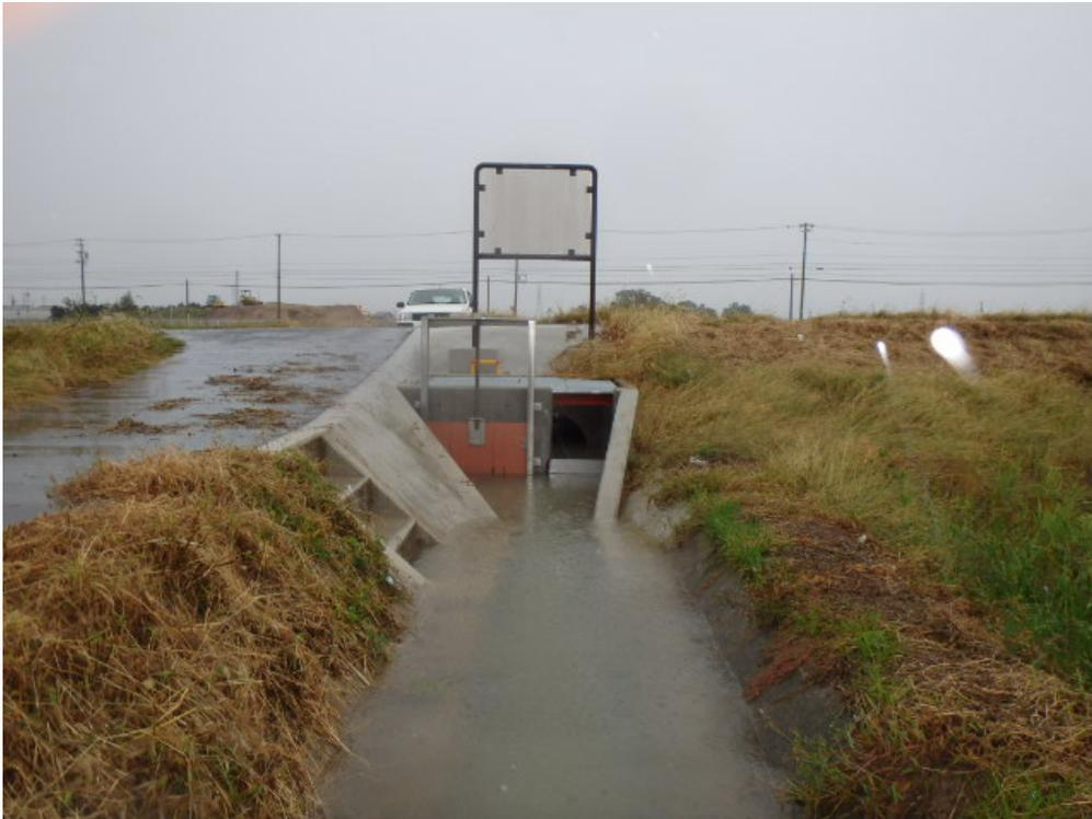
(写真：調整マス) 雨水はせきの高さまで貯まり、調整マスの効果がみられました
