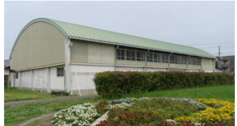
屋内運動場 外観
