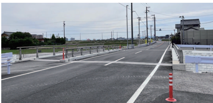
計画的に更新された橋りょう
