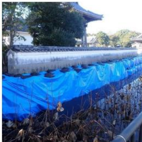
崩壊が懸念されるため大型土のうで保護した本證寺の石垣。 (4年度に石垣を解体修理)
