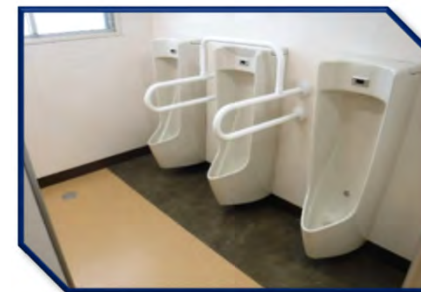
手すりの設置・自動洗浄
