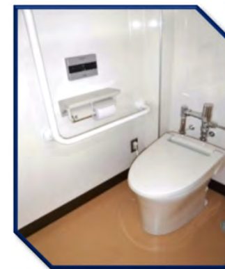
便器の洋式化・手すりの設置
