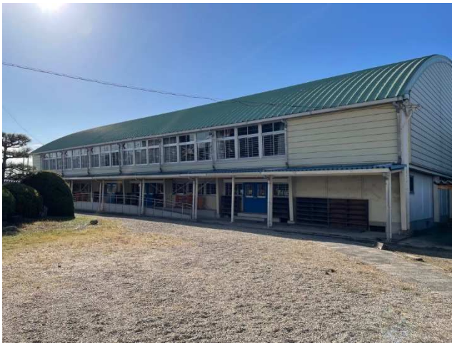
屋内運動場 外観
